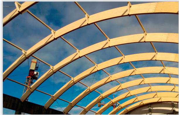
KONSTRUKCJA DACHOWA NAD BASENEM – KOSAKOWO K. GDYNI
